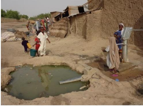
Figure 43 Forage (NDJ 24) à Ndjari contaminé par bactéries fécales.
