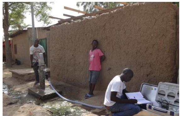
Figure 42 Forage (NDJ 4) à Moursal à proximité des ménages avec drainage des eaux grises fortement contaminées par les bactéries fécales.
